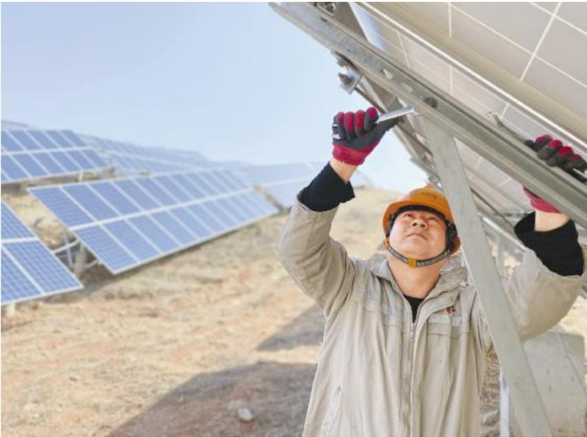
朝阳光伏电站运维人员紧固螺栓,保障安全
