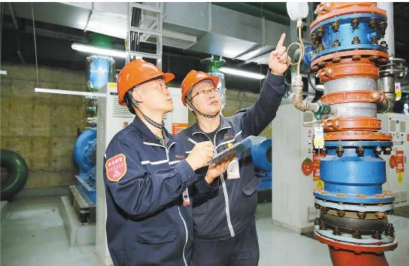
检查地下水泵房消防管网水压
