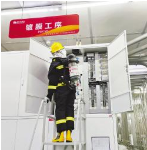
氨气泄漏演练
