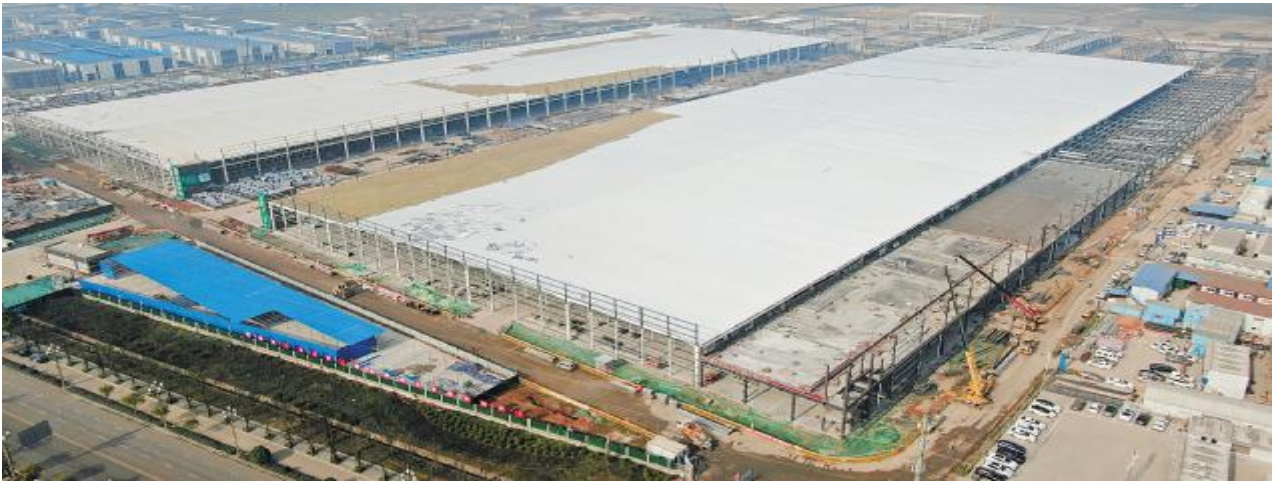
2023 年 4 月,建设中的通威太阳能彭山基地
