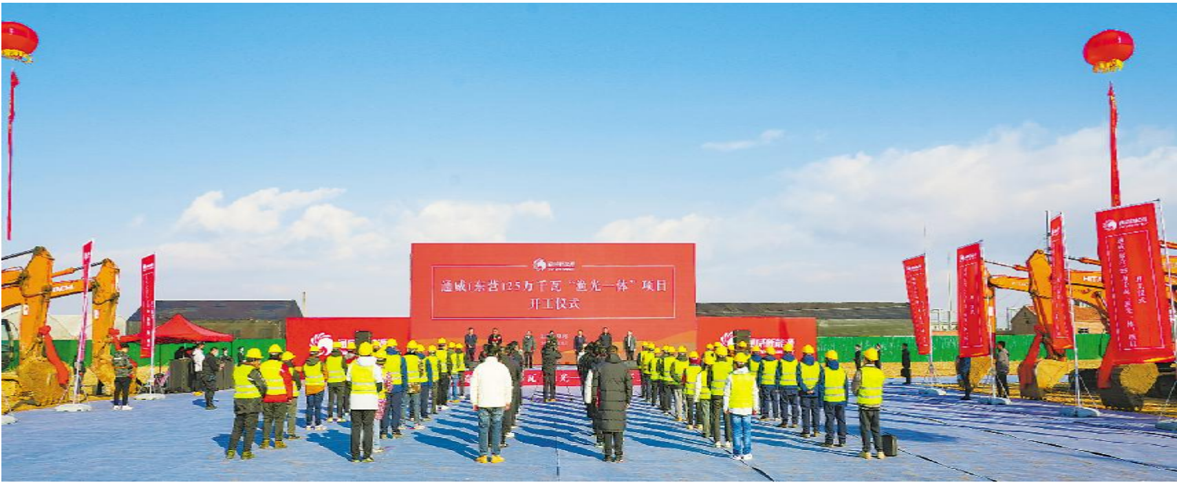
通威东营“渔光一体”二期项目开工
