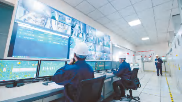
通威农发智能化车间中央控制室
