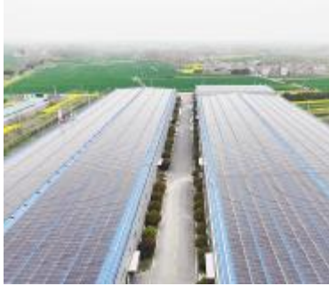
湖北永浩泰德分布式光伏电站
