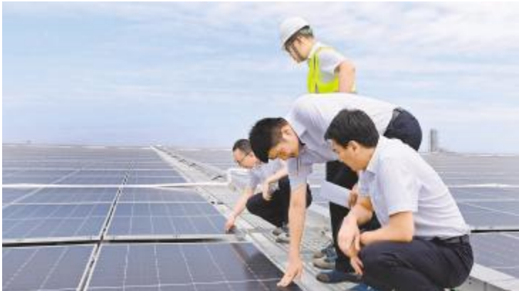
通威太阳能科技盐城基地综合安全大检查现场
