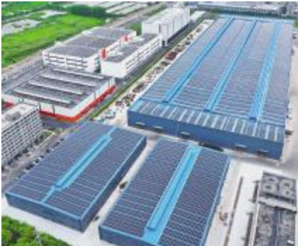
芜湖博天智能装备有限公司光伏发电项目
