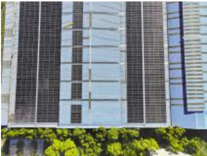
阳光铝业二期光伏发电项目
